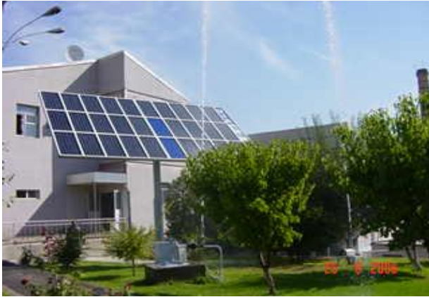
Նկ. 4.15. Արևային պոմպային ջրհան կայանք “Վիասֆեր Տեխնոպարկ” ՓԲԸ-ի տարածքում
